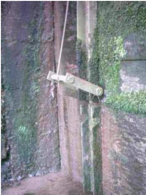
Abb. 5: Koppelmechanismus für Gleitschütz mit horizontale geteilter Tafel
